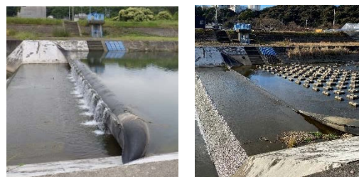
図2. 堰による水位操作
