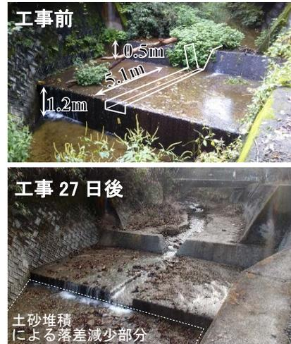
写真-1 竜の口溪谷堰堤の工事前(上)と工事後(下)
