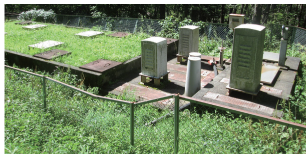
写真2. 溝口地区の浄水場 (2019年9月12日撮影) Photo 2. Water treatment plant in Mizoguchi district.
