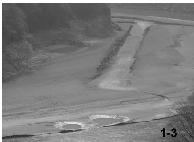
図1. 天竜川の河川水の濁りとダム湖の堆砂（2008年度の流水掃砂時に撮影）。
