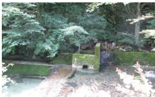
写真3 鈴ヶ沢中越橋周辺の用水取水口
